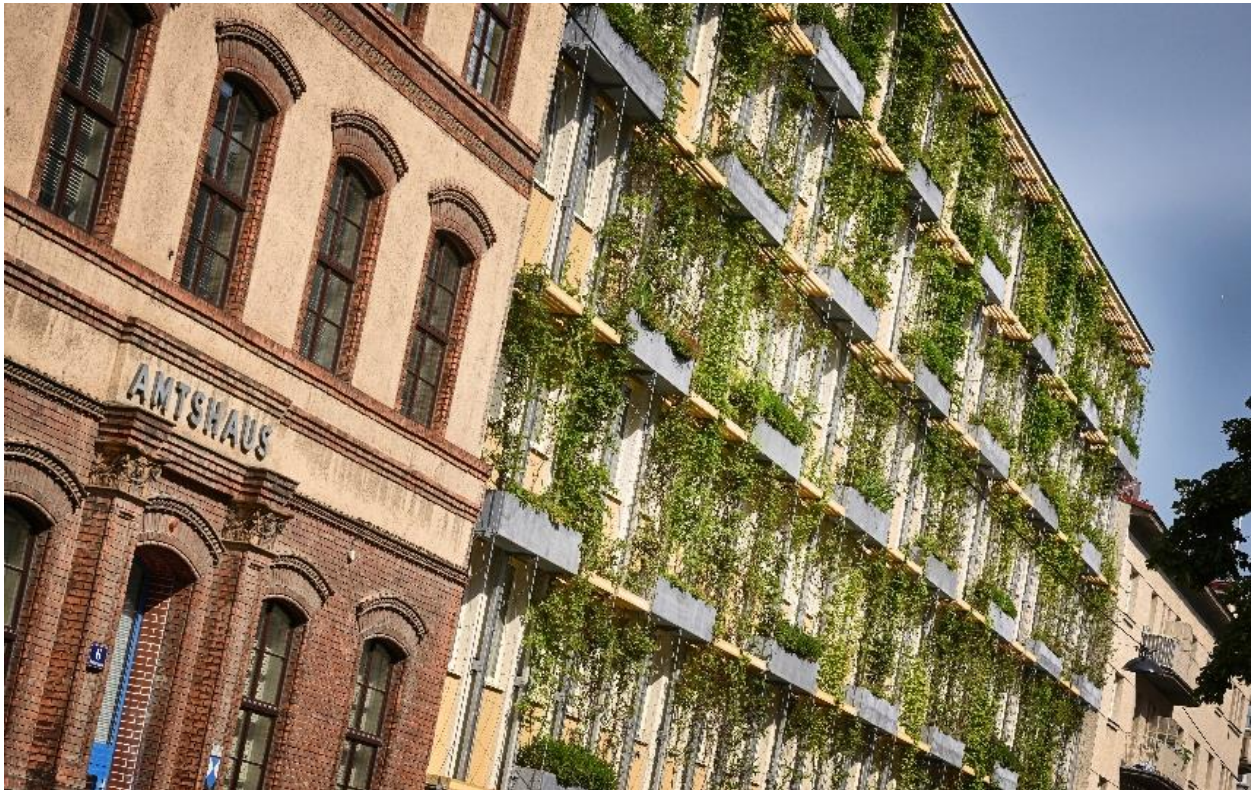
Abbildung 1: Begrünte Fassade am Amtsgebäude der Magistratsabteilung 31 - Wiener Wasser
